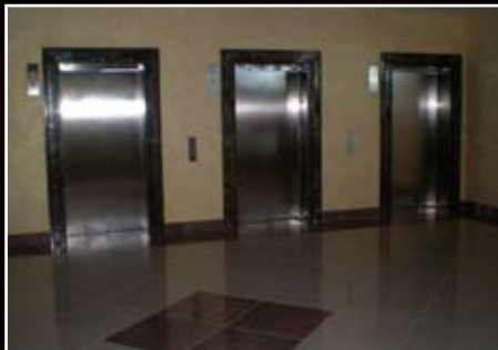
Мраморные наличники лифтовых проёмов в офисном здании турецкой строительной компании «ОДАК» г.Казань
