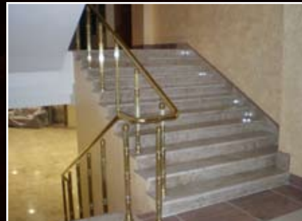
Лестница из мрамора «Shivakashi Gold» в офисном здании турецкой строительной компании «ОДАК» г.Казань
